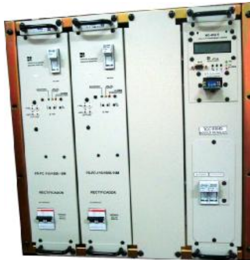
Sistema OM- Sub Rack con 4 módulos
